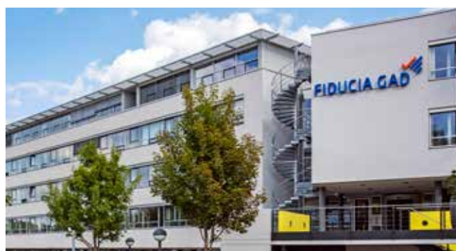
Fiducia & GAD, Standort Karlsruhe
